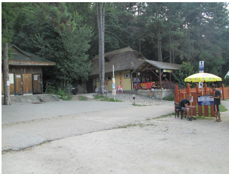
A Sajkodi strand erdőbe létesített kiszolgáló épületei.
