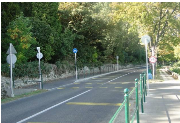
A 7117. j. mellékút a vízmű területnél
