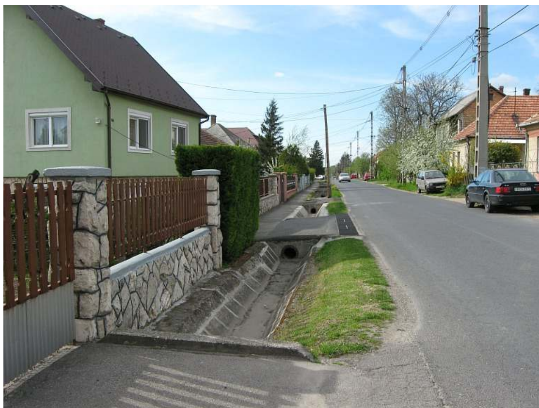
4. ábra. Helyszínrajzi és magassági összhang-hiány a vízelvezetés és a járdaépítés között. (Győr-Ménfőcsanak, Ménfői u. északi szakasza)
