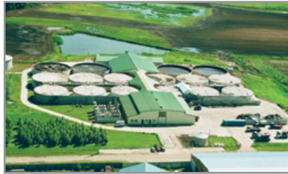
Nyírbátor biogas plant (herbator.hu)
