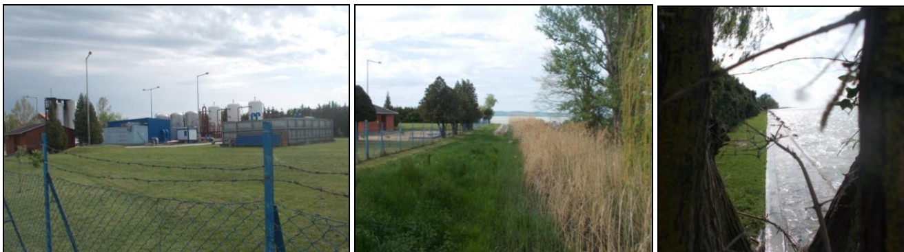
A 663 hrsz-ú vízmű, a mellette lévő út és „Nagymetszés” árok ill. a vízmű előtti partszakasz (951 hrsz)
