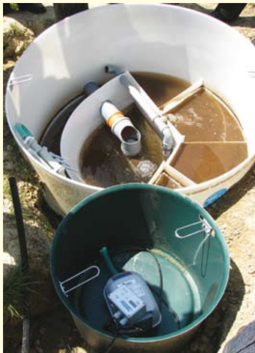
7. sz. kép: Egyedi szennyvízkezelő berendezés beüzemelés alatt
