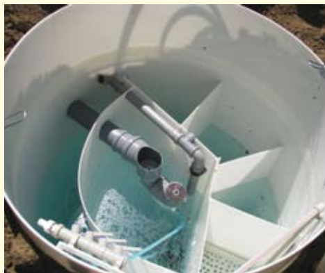
5-6. sz. kép: A két különböző típusú egyedi szennyvízkezelő berendezés talajba süllyesztett műanyag hengere belülről
