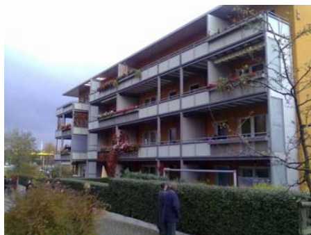
22. ábra: Dreza, panelrehabilitáció: visszabontás 6 emeletről 3-ra, független teraszok
