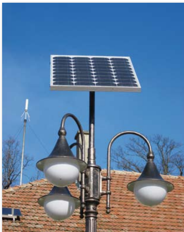
A kerékpárút mentén elhelyezett napelemekkel és LED-lámpákkal ellátott oszlopok
