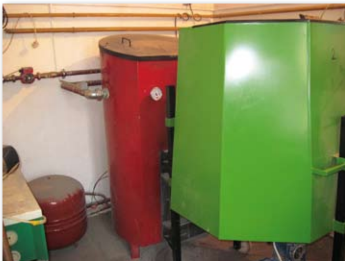
Az aprítékadagoló berendezés és a kazán, illetve a kettőt összekapcsoló adagolórendszer
