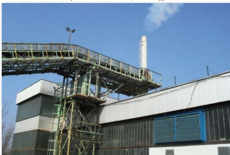
A faapríték betárolása és futószalaggal történő továbbítása
