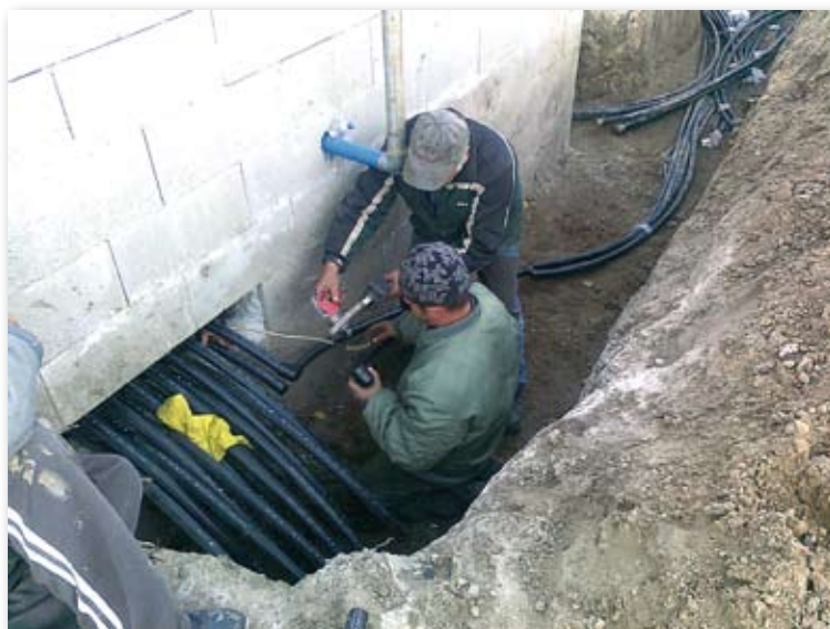
A geotermikus energiát szállító csövek bevezetése az épületekbe
