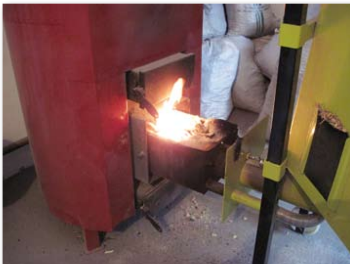
Az aprítékadagoló berendezés és a kazán, illetve a kettőt összekapcsoló adagolórendszer
